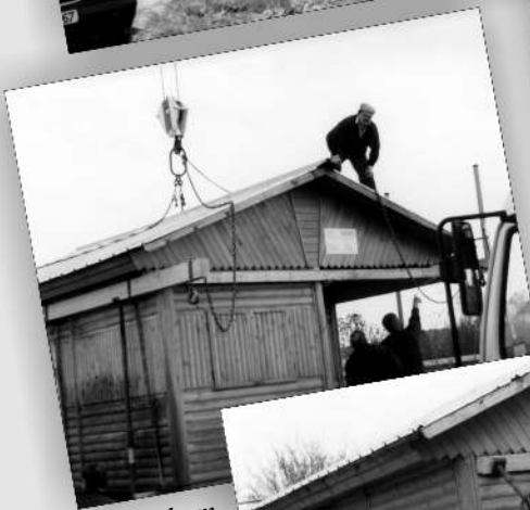
Das Häusl wird am Kran befestigt
